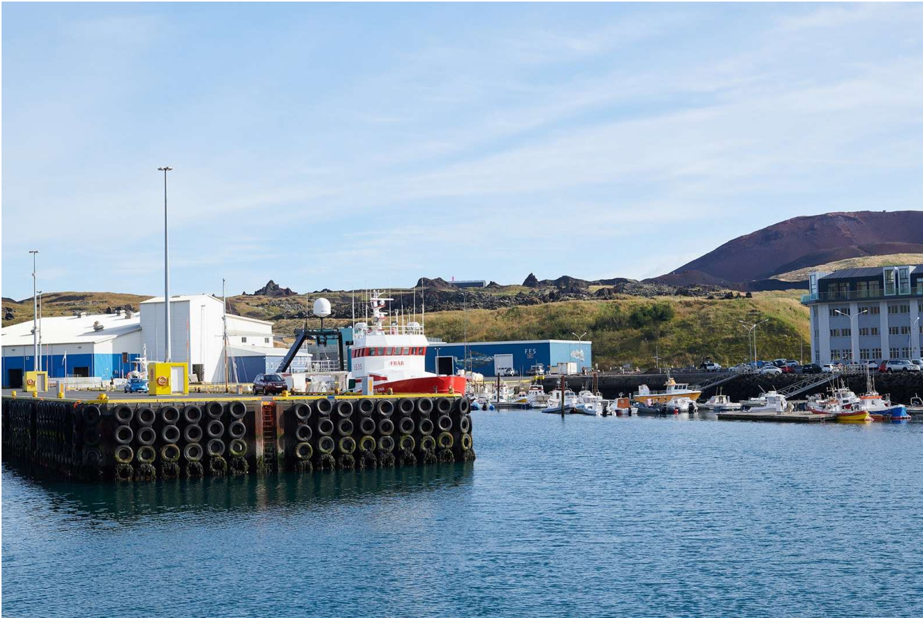
Mynd 3.14. Ásýnd frá höfninni sem gefur vísbendingu um hvaða breytingar verða á ásýnd. Stækkun á húsi sést ekki en nýr strompur sést.
